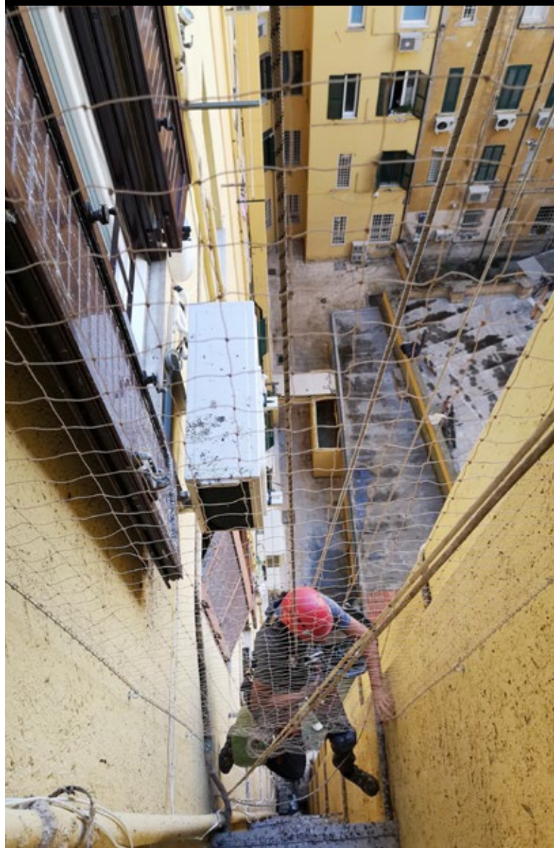
INSTALLAZIONE RETE ANTI PICCONI
