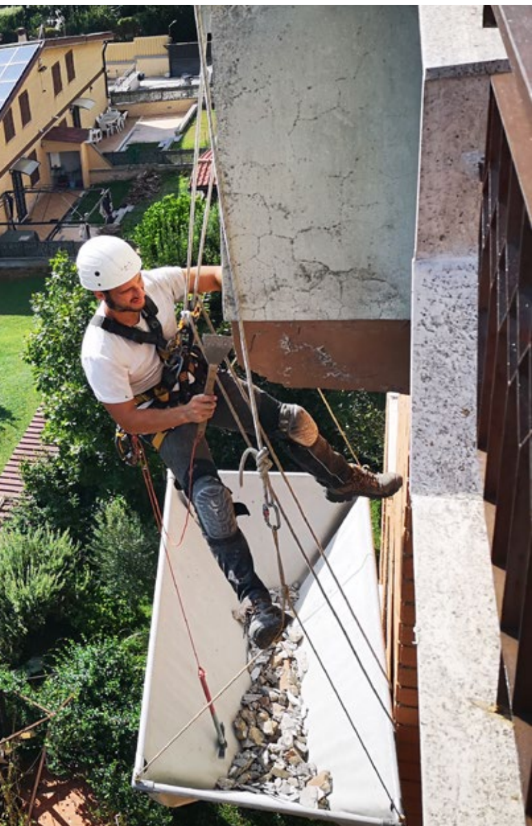
RIMOZIONE DEL PERICOLANTE
