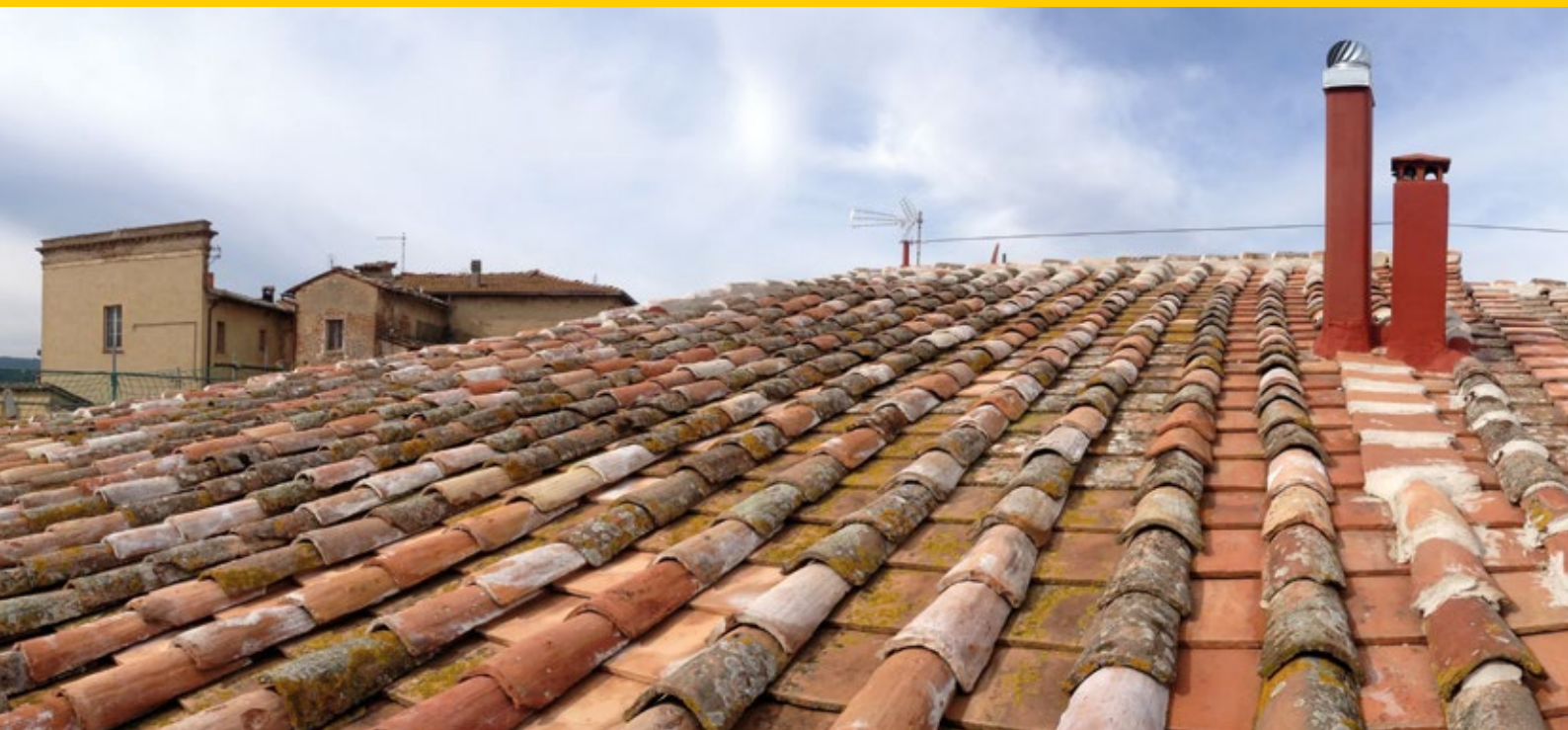
INSTALLAZIONE LINEA VITA E RIPRISTINO TOTALE COPERTURA
